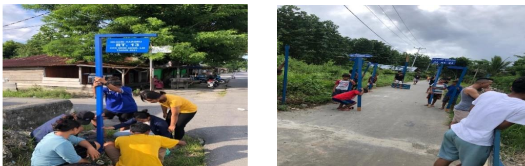
Gambar 5. Pemasangan Papan Nama
