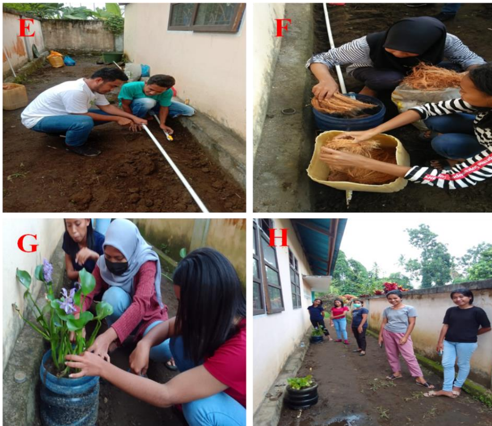
Gambar 4. Proses pemasangan instalasi wetland buatan. Keterangan lainnya: E) Pemasangan pipa untuk aliran limbah; F dan G) Memasukkan material berupa sabut kelapa dan enceng gondok; H) Hasil Instalasi wetland buatan
