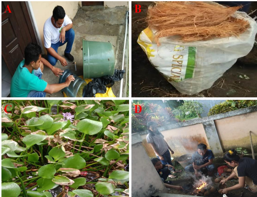
Gambar 3. Persiapan alat dan material wetland buatan. Keterangan lainnya: A) Wadah penampung dan tempat wetland buatan; B) Sabut kelapa; C) Enceng gondok; D) Pembuatan arang dari batok kelapa
