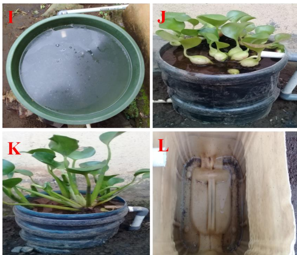
Gambar 5. Limbah cair rumah tangga pada instalasi wetland buatan. Keterangan lainnya: I) Wadah penampung limbah; J) Wetland buatan, tempat filtrasi pertama; K) Wetland buatan filtrasi kedua; L) Wadah penampung hasil akhir pengolahan limbah
