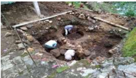
Pekerjaan Galian & Pembesian
