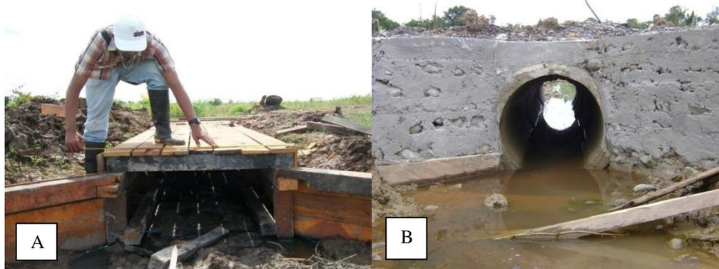
Gambar 5. Konstruksi gorong-gorong kayu dan beton: A) proses pelaksanaan; B) hasil pekerjaan
